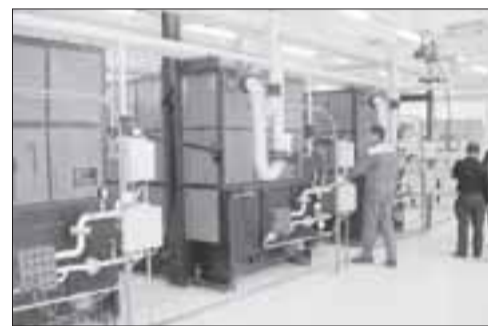
Пусковые работы на газовой котельной в селе Шаркан
