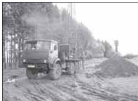
Бурение скважины на воду
