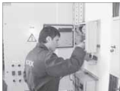
Наладка частотных регуляторов системы горячего водоснабжения котельной ГЛК Чекерил
