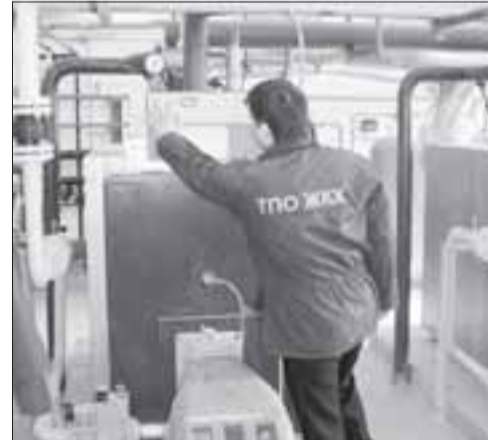
Пусковые работы в котельной Чекерил
